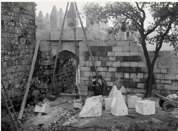
A roldana é acionada por uma corda que ao girar em torno de um eixo central modifica a direção da energia e diminui a força necessária para erguer um objeto pesado. Com recurso a este sistema simples, mas eficaz, o canteiro medieval foi autor de verdadeiras construções megalómanas que, pela sua imponência arquitetónica, ainda nos dias de hoje impressiona qualquer visitante.
